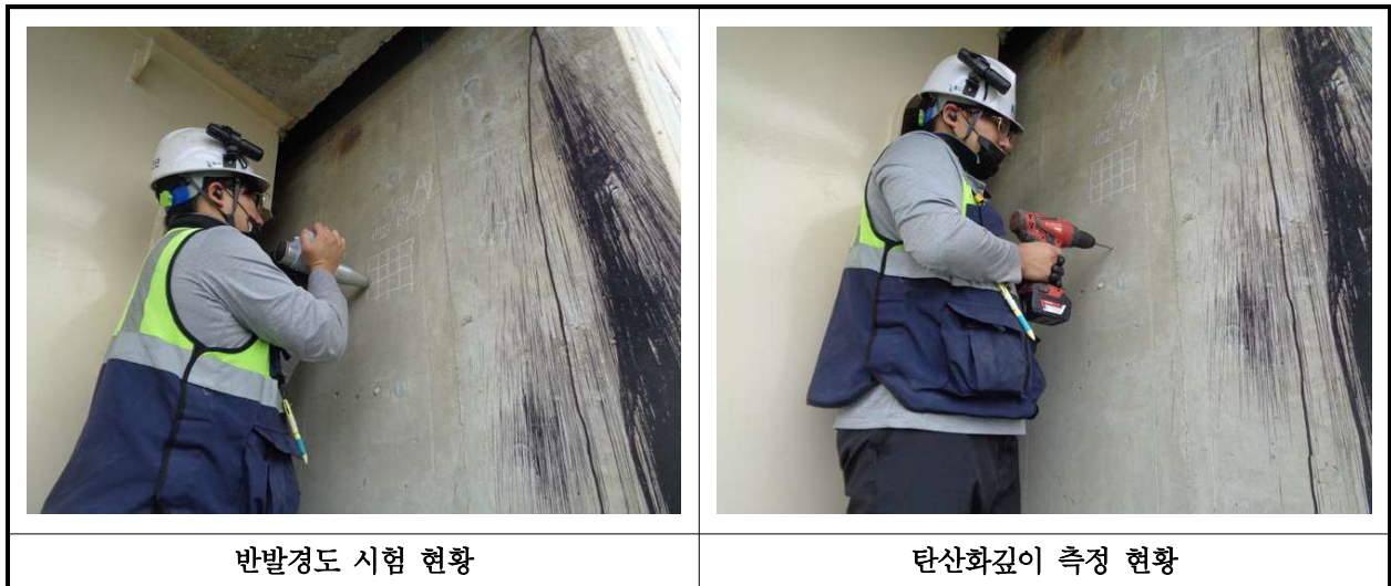
【사진 42.4.1】 콘크리트 내구성조사 현황
