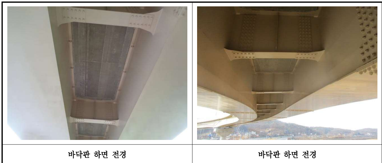
【사진 42.3.2】 바닥판하면 전경
