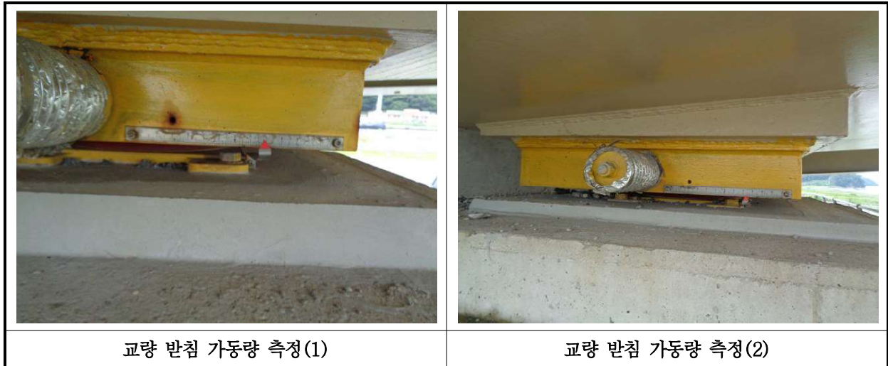
【사진 42.3.15】 교량받침 이동량 측정
