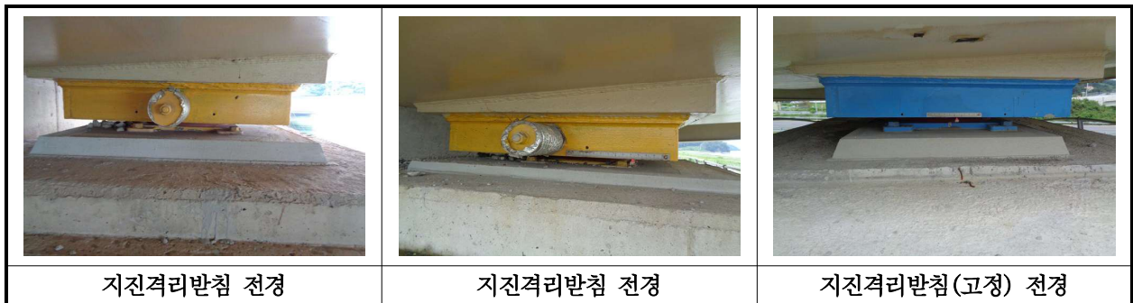
【사진 42.3.12】 교량받침 전경
