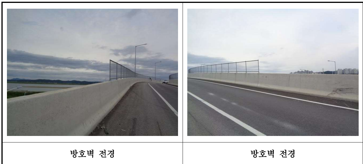
【사진 42.3.23】 방호벽 및 중앙분리대 전경
