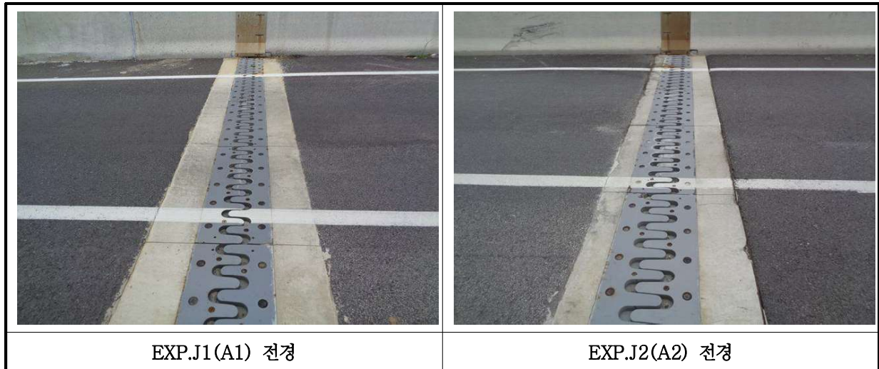
【사진 42.3.16】 신축이음장치 전경
