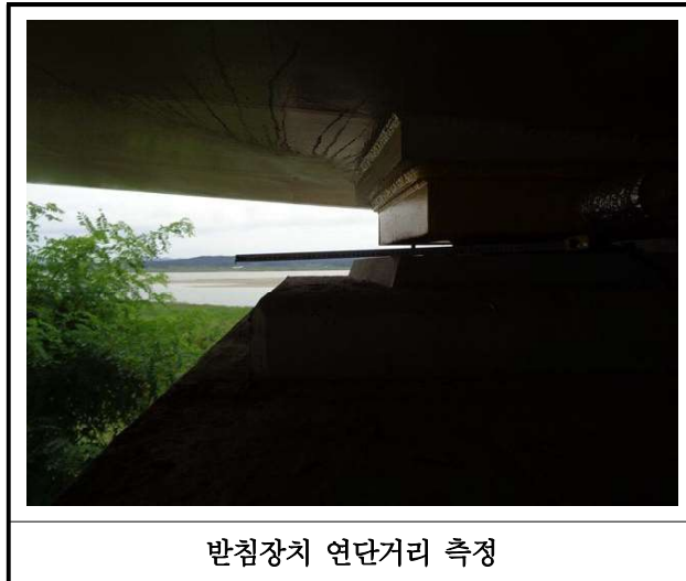
【사진 42.3.14】교량받침장치 연단거리측정
