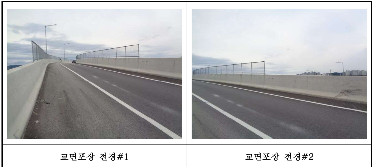
【사진 42.3.19】 교면포장 전경
