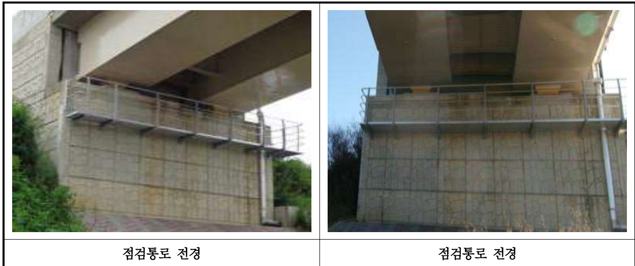
【사진 42.3.25】 교량 점검시설 전경
