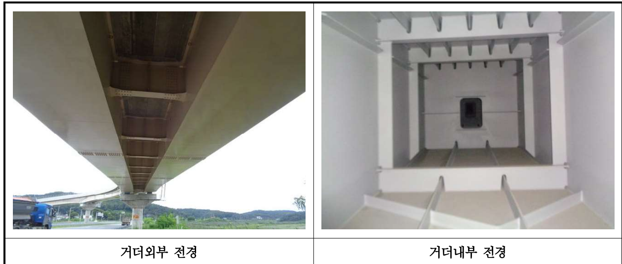
【사진 42.3.4】 거더 전경
