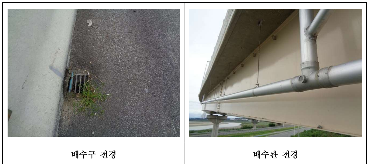
【사진 42.3.21】 배수시설 전경
